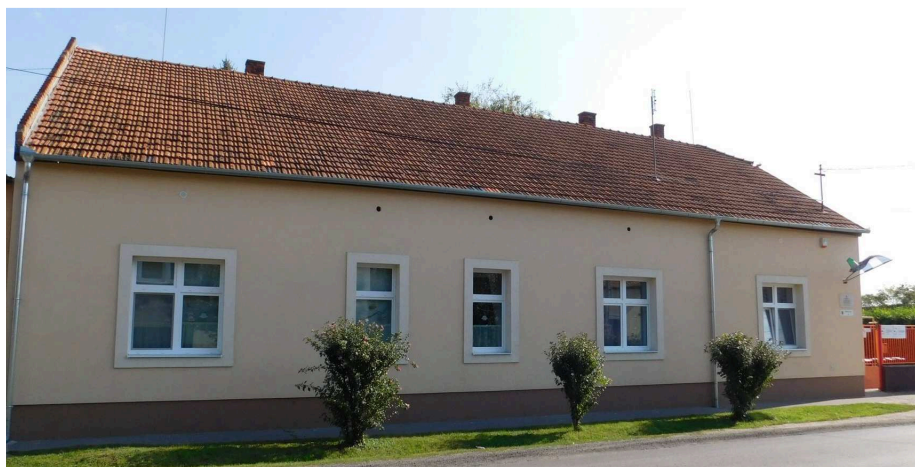
Rákóczi utca 30. Az előbbiekhöz egykor vélhetően hasonló, polgári ízléssel kialakított épület, amelynek az idők viharában lekopott; a homlokzat felújítása az állagvédelem követelményének megfelel, de a korabeli részletgazdagságot meg sem kísérelte visszahozni.
