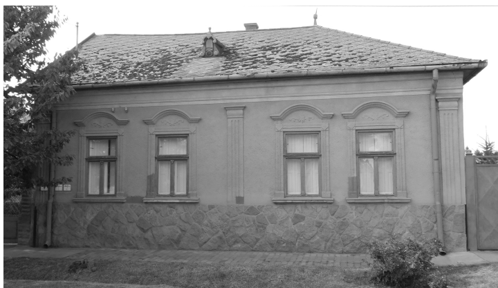
Széchenyi utca 3, kellemes arányú homlokzat, meglévő, igényes vakolatdíszekkel.
